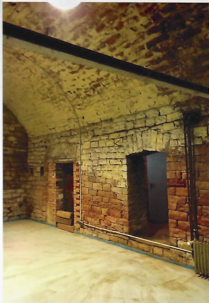
Der fertig gestellte Durchbruch der historischen Tür.
