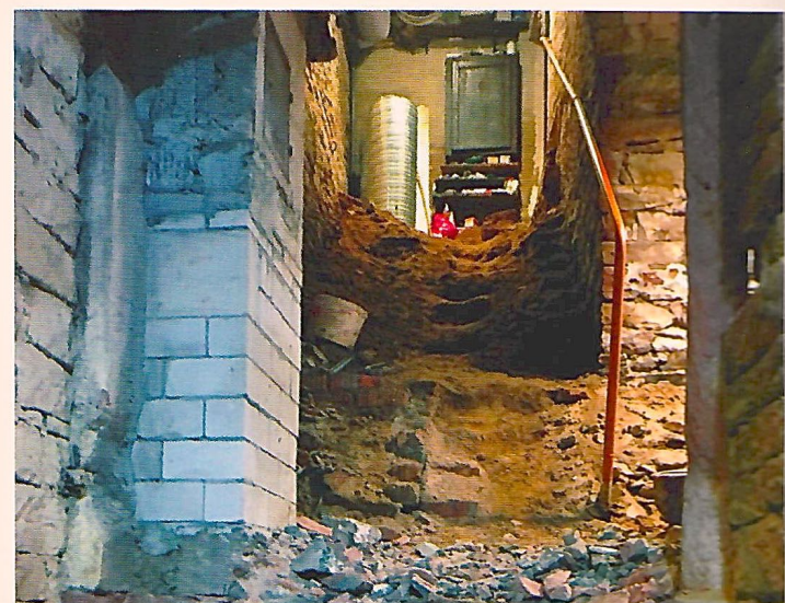
Treppenabgang Januar 2018, nach der Sandsteinentfernung.
