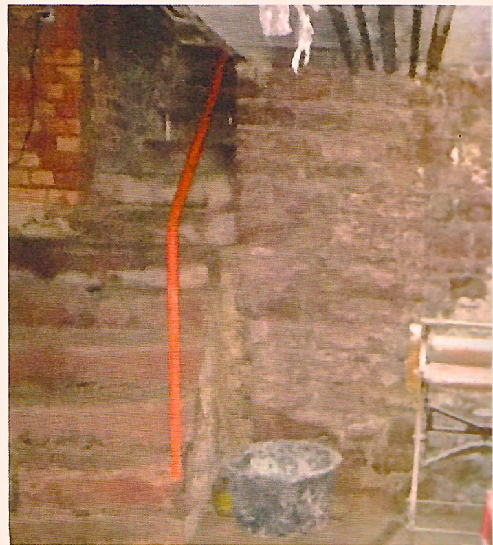
Treppenabgang 2014 ehemalige „Bierquelle“.
