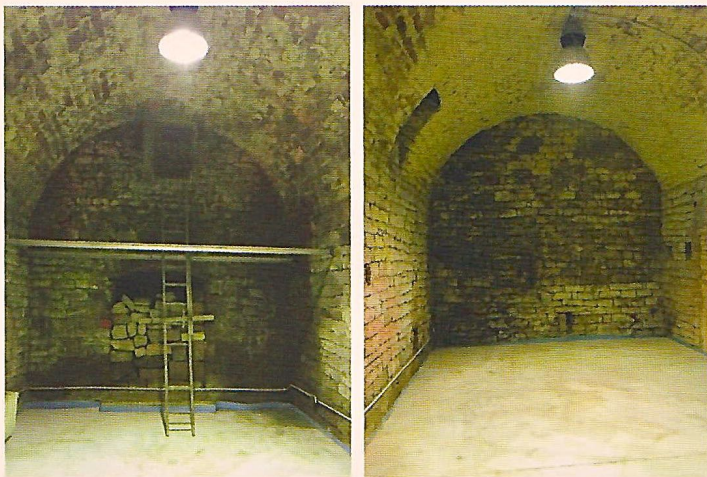
Gewölbekeller „Bierquelle“ 2018, während der Renovierung.
